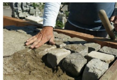
Wegplatten werden mit Sand befüllt.
