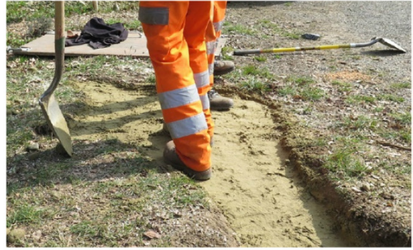
Kompakt mit Sand auffüllen.
