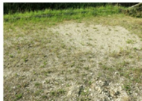
Eben eingebaute Sandlinse.
