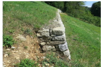
Abbruchkante vom Trockenmauerbau. (Vogelrüti AG)
