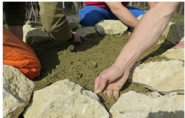
Gut hinterfüllen und festdrücken.
