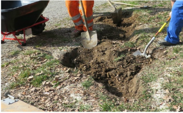
Grasnarbe entfernen, Mulde ausheben.
