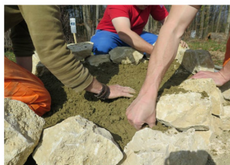
Sand wird kompakt in die Hinterfüllungen gedrückt.
