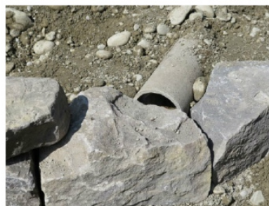
In die Trockenmauer sind Hohlkammern unter anderem für Hummeln eingebaut.
