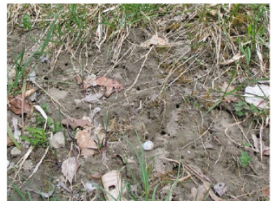
Nach Regen können die Aushube weggespült sein.
