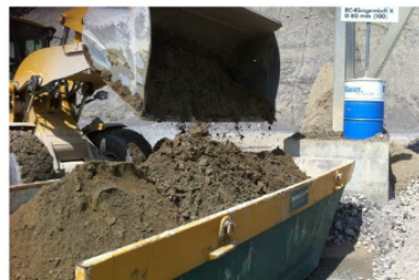
Der Bagger in der Sandgrube füllt das gewählte Substrat in die Mulde.
